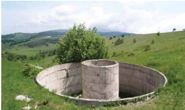
Фундамент ВЭС на горе Ай-Петри
